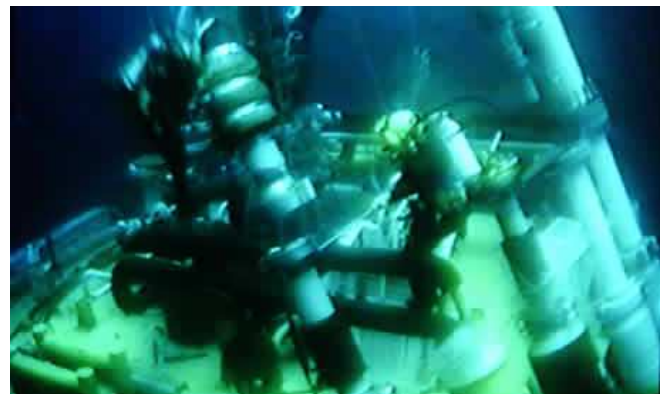
Figure 13: Connexions sur les têtes des tours
