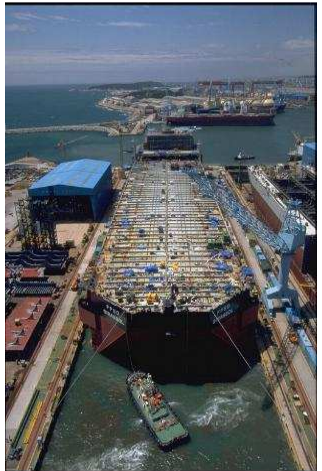
Figure 17: sortie de cale sèche de la coque
